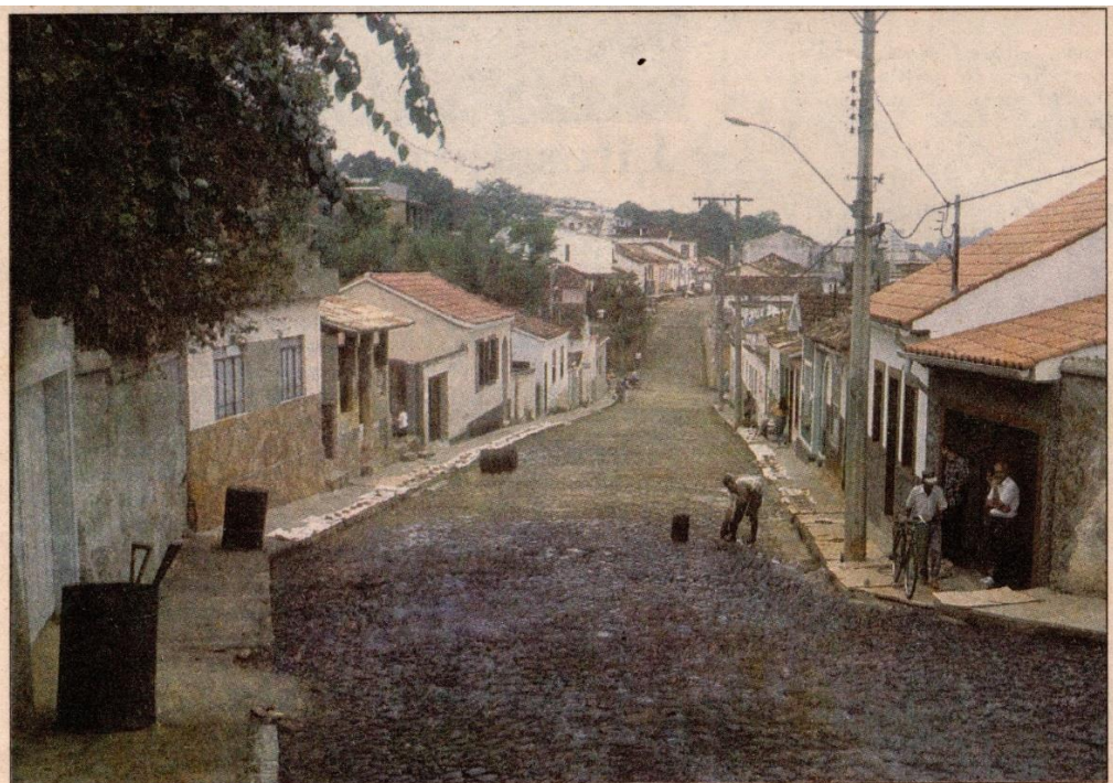
Apesar das ameaças de embargo, as obras de asfaltamento da rua Santo Antônio prosseguiram ontem
