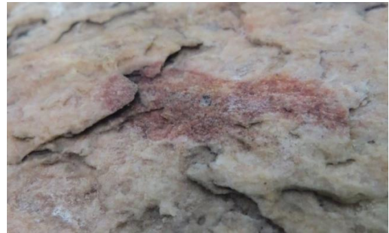
Ampliação de uma pintura elipsoide: contornos nítidos, conservados nitidamente entre as observações de 2014 e 2023. Risco de desprendimento por escamação de uma parte.
