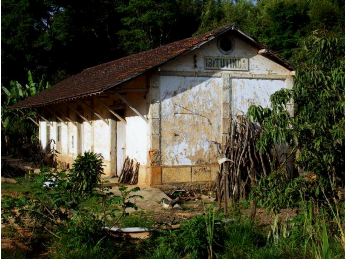
Aspecto atual da Estação de Ibitutinga (foto do autor - 28.09.2009).
