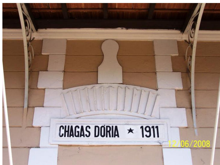
Detalhe da Estação Chagas Dória (foto: J. A. Ávila - 2008)
