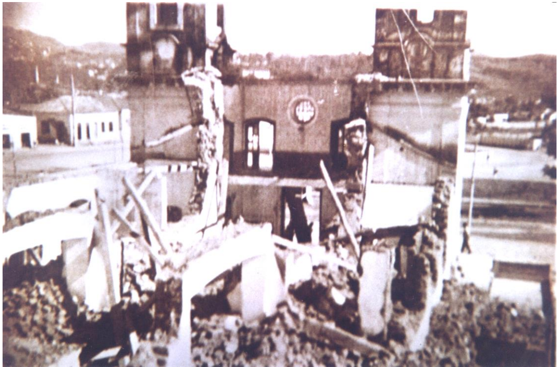
A demolição, em 1970 (arquivo: José Antônio de Ávila)
