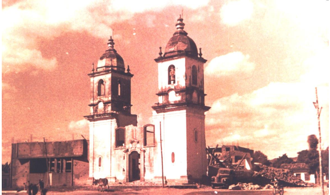
Aspecto da demolição da Igreja, em 1970 (foto: arquivo de J. A. Ávila)
