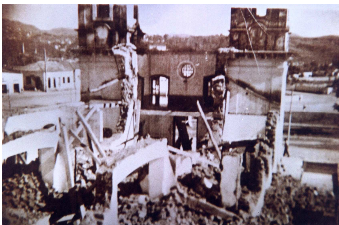
Aspecto da demolição da Igreja do Senhor Bom Jesus de Matosinhos
