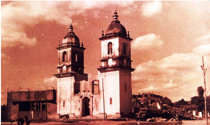
Demolição da primitiva Igreja do Senhor Bom Jesus de Matosinhos Note-se que a igreja nova surge por detrás da antiga, o que comprova que uma caberia junto a outra.
