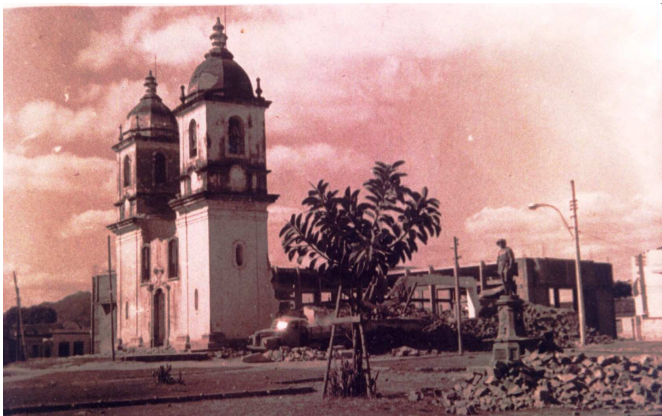
Aspecto da demolição da Igreja do Senhor Bom Jesus de Matosinhos.
