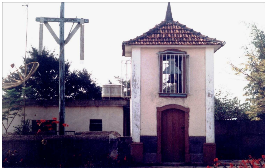
Cruzeiro e campanário da igreja de Nossa Senhora da Vitória; o campanário, como era costume, foi construído em torre separada do corpo da capela (arquivo do autor).
